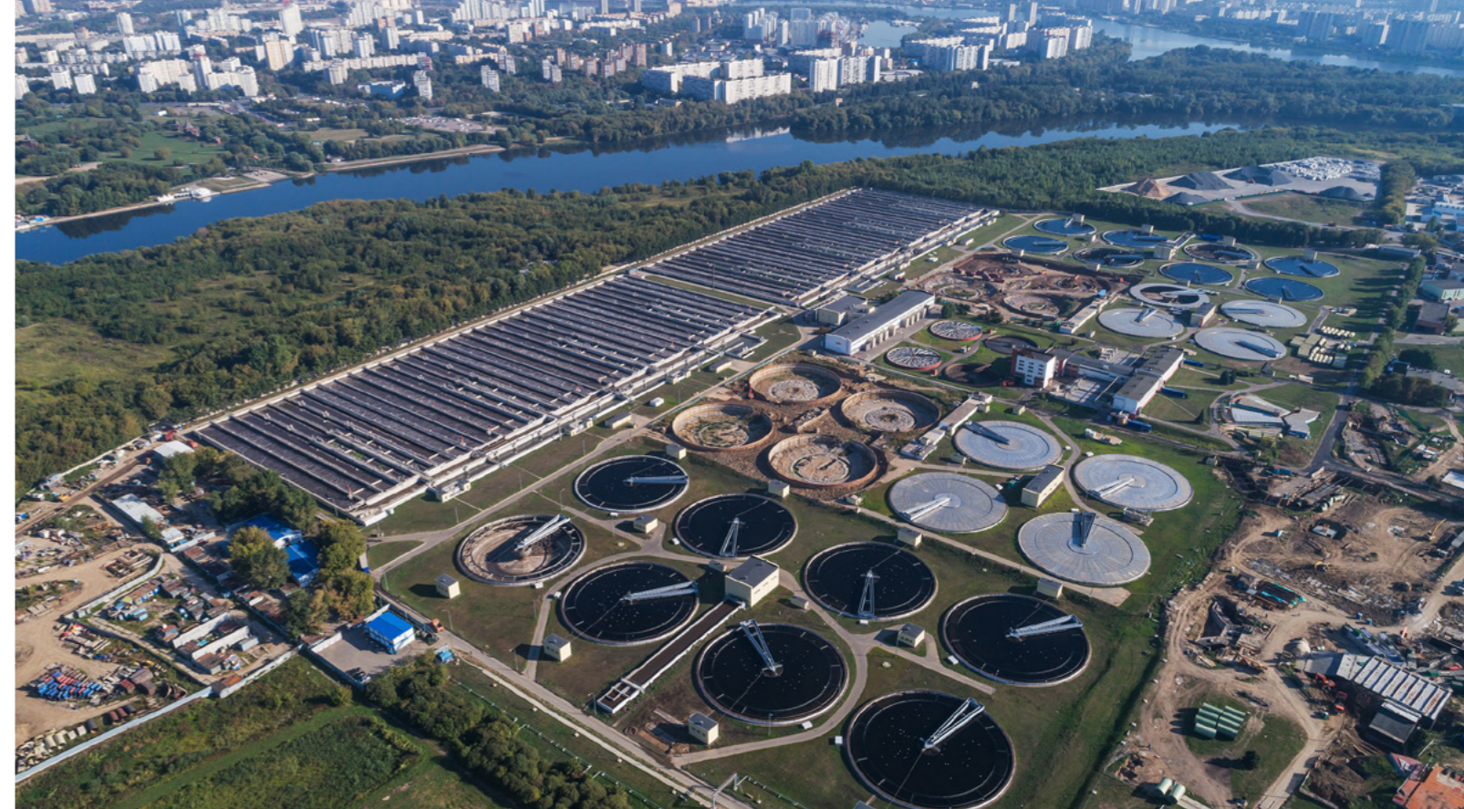
Курьяновская очистная станция в Москве. Источник: A. Savin, WikiCommons
