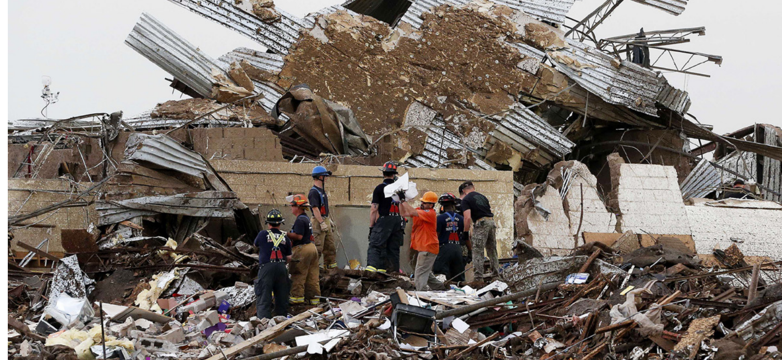
Последствия смерчей бывают разрушительны
